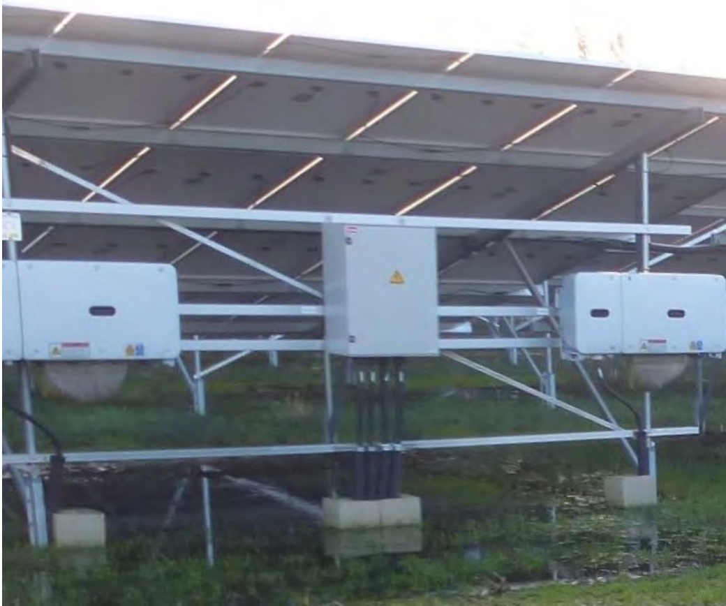
Figur 5-9 Inverterne er små bokse, der placeres under solpanelerne.
