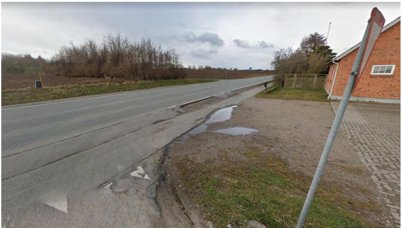
Figur 1-12 Oversigt i krydset Gl. Århusvej/Østerskovvej fra Østerskovvej mod vest (mod højre). Kilde: Google Maps, 2022.
