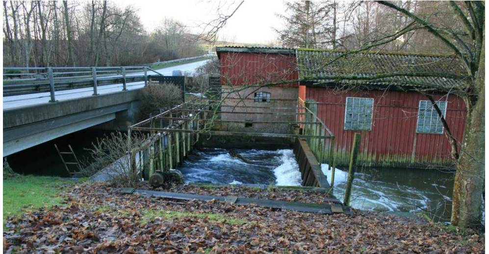
Figur 1-2 Stemmeværket og ålekisten (bygningerne forventes renoveret når stemmeværket er fjernet)
