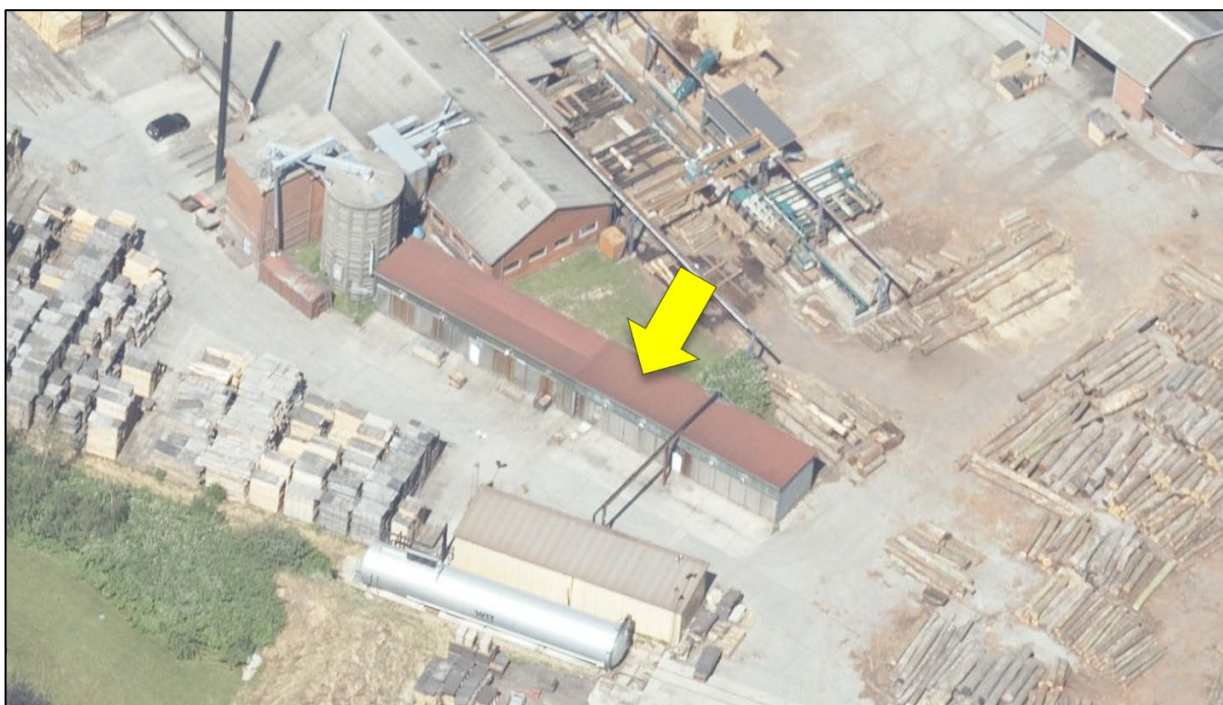
Bygning 4c). Luftfoto fra 2020, der viser den 235 m 2 store bygning.
