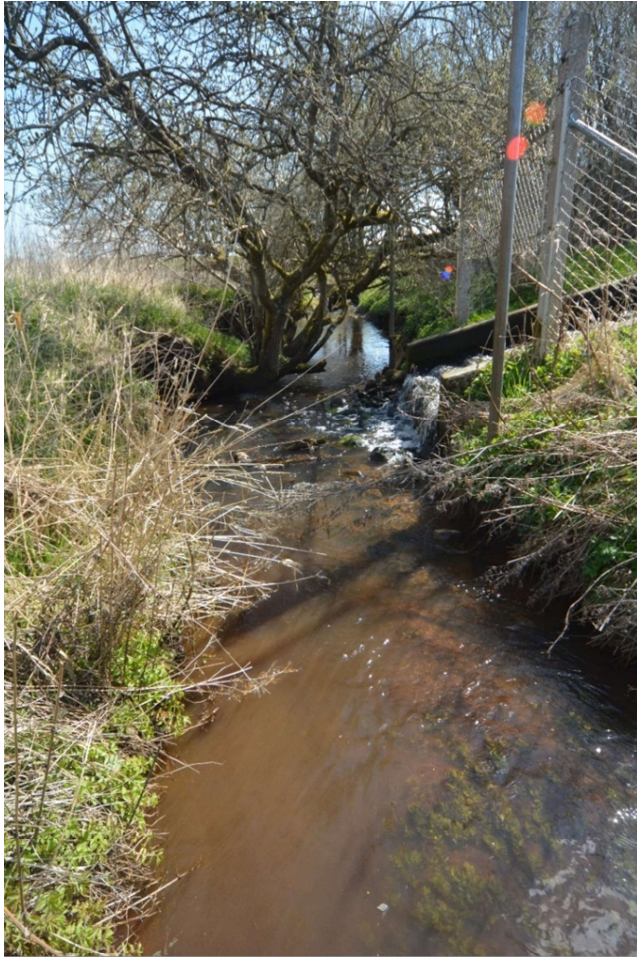
Figur 7: Nuværende udløb fra renseanlæg over iltningstrappe til Lyngbygård å
