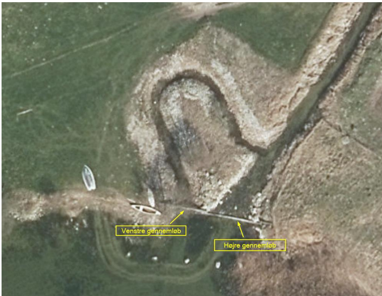
Figur 3 Oversigt over udløbsbygværk med venstre og højre gennemløb.
