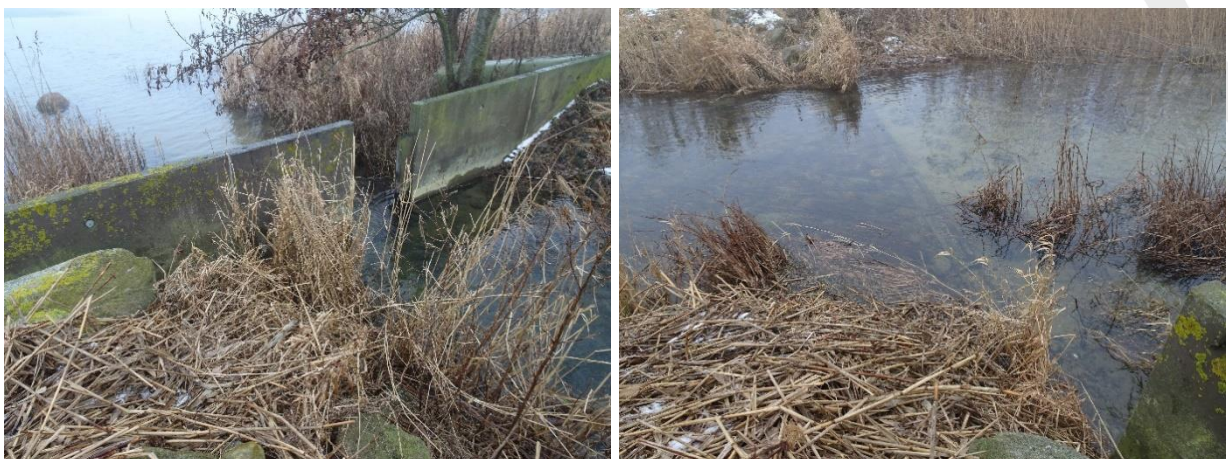
Figur 4 Venstre og højre gennemløb i bygværket.
