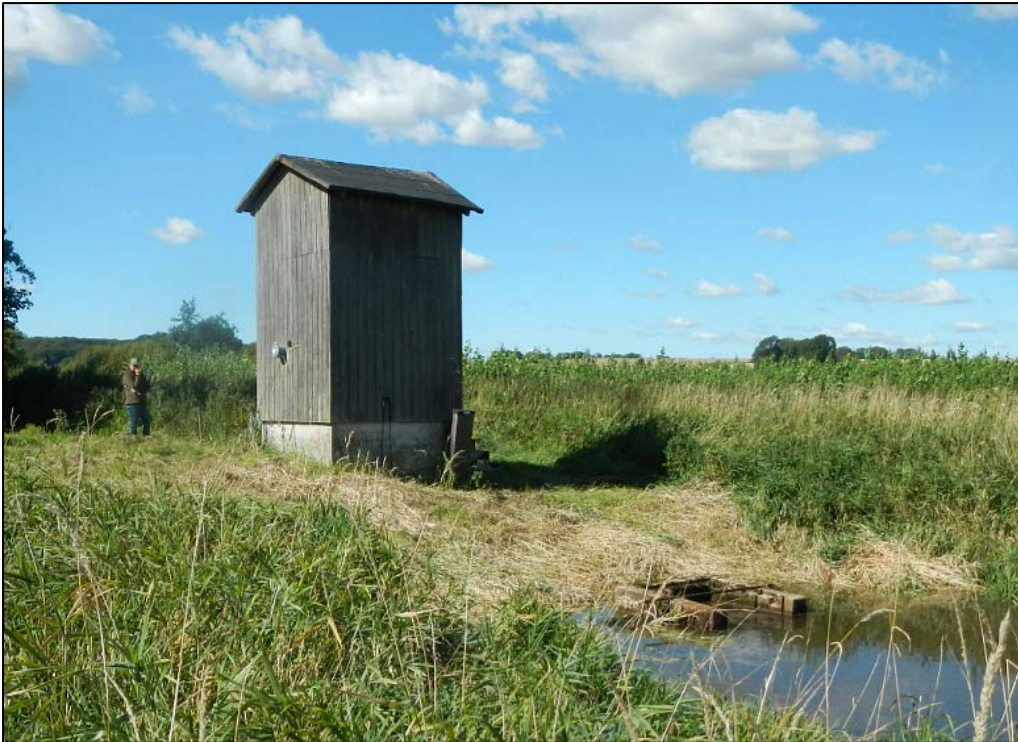
Figur 2-20. Billede af pumpestation med indløbsbygværk og den centrale afvandingskanal.
