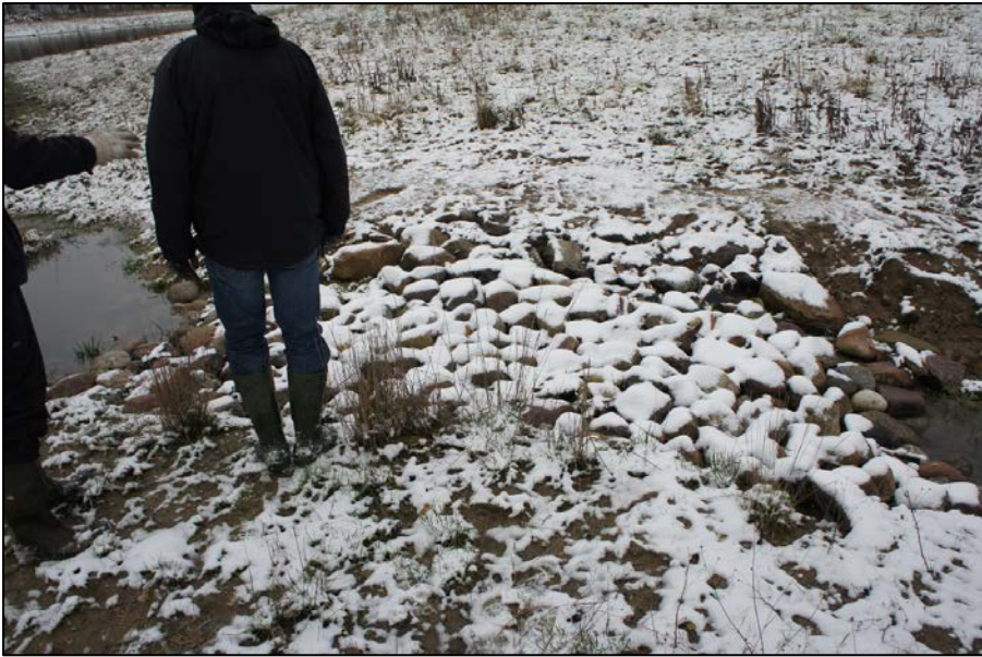
Figur 3-2. Eksempel på en overløbstærskel mellem en sø og et vandløb.
