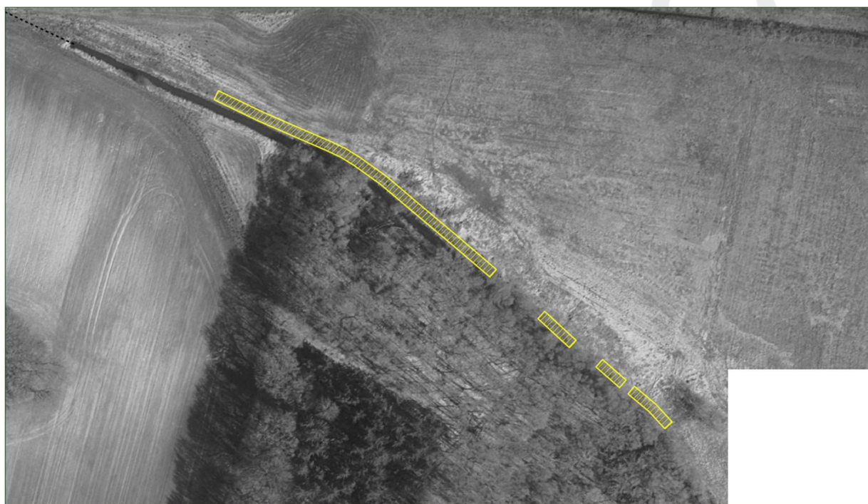
Figur 4. Illustration af det nye udløbsbygværk mellem projektområdet og Knud Å. Bundkoten i indløbsrøret er sænket til koten 23,65 m DVR90, for at sikre at det projekterede vandspejl på 23,67 m DVR90 ikke overstiges.
