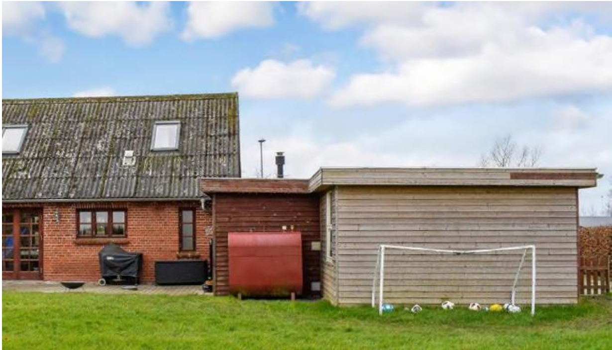
Billede fra ansøgningsmateriale. Udhusets østfacade ses på billedet.
