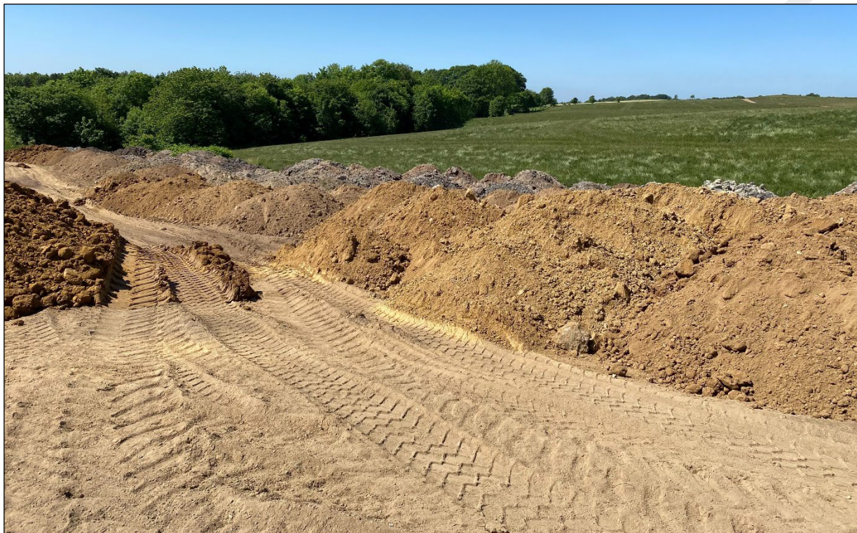
Foto C. 07.06.2023. Overskudsjord, der er kørt ud i en naturlig lavning NØ for bygningerne på Krogdalsvej 8. Foto taget fra N mod S.
