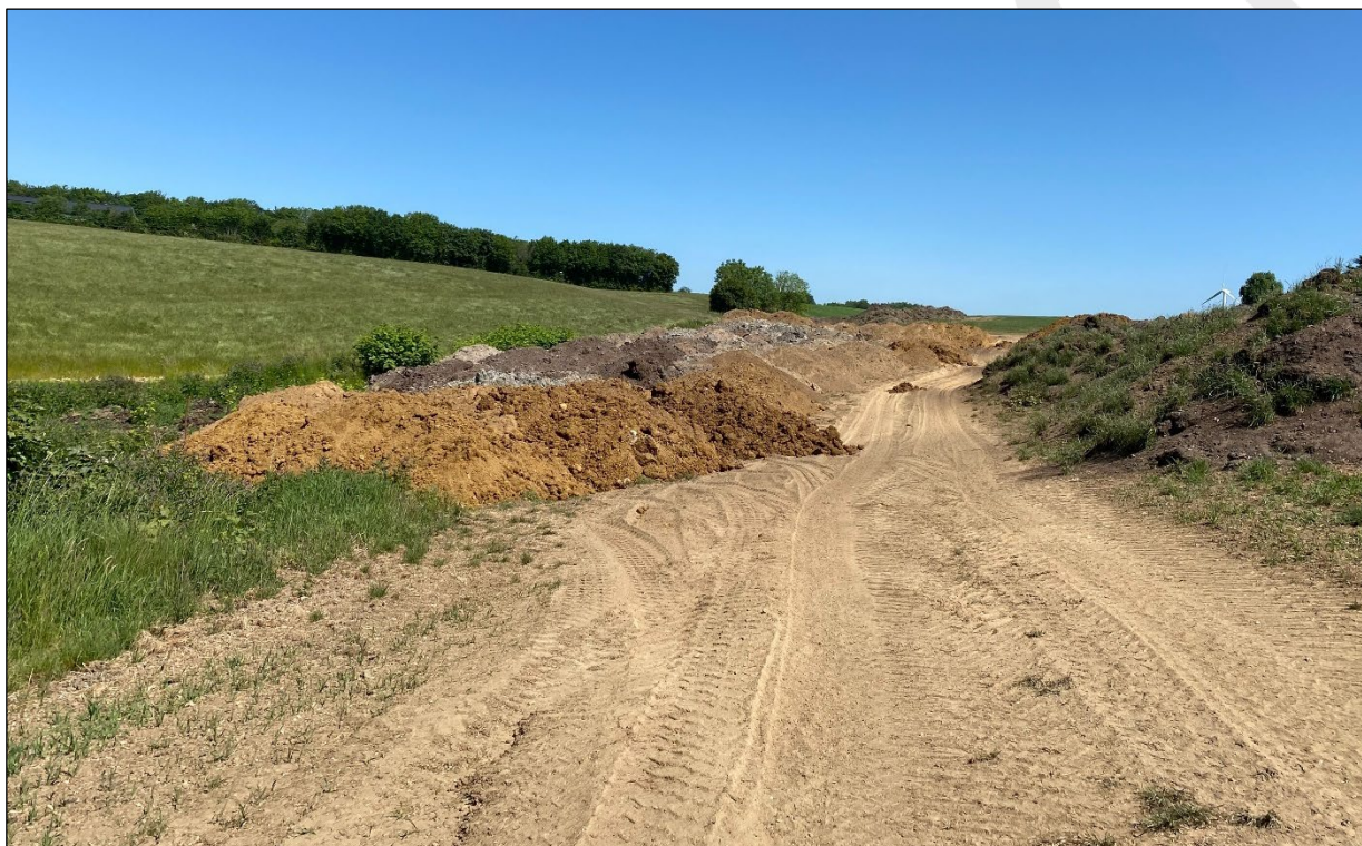
Foto D. 07.06.2023. Overskudsjord, der er kørt ud i en naturlig lavning NØ for bygningerne på Krogdalsvej 8. Foto taget fra S mod N.
