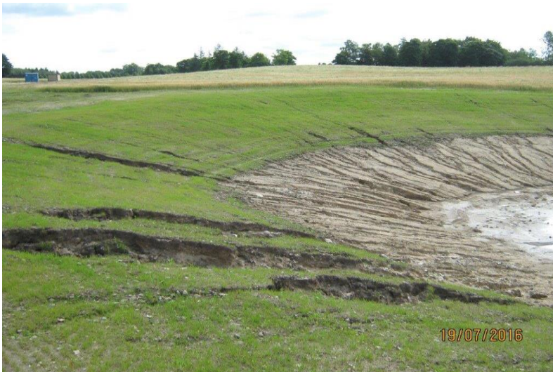
Figur 4: Nyt bassin med dybe skyllerender
