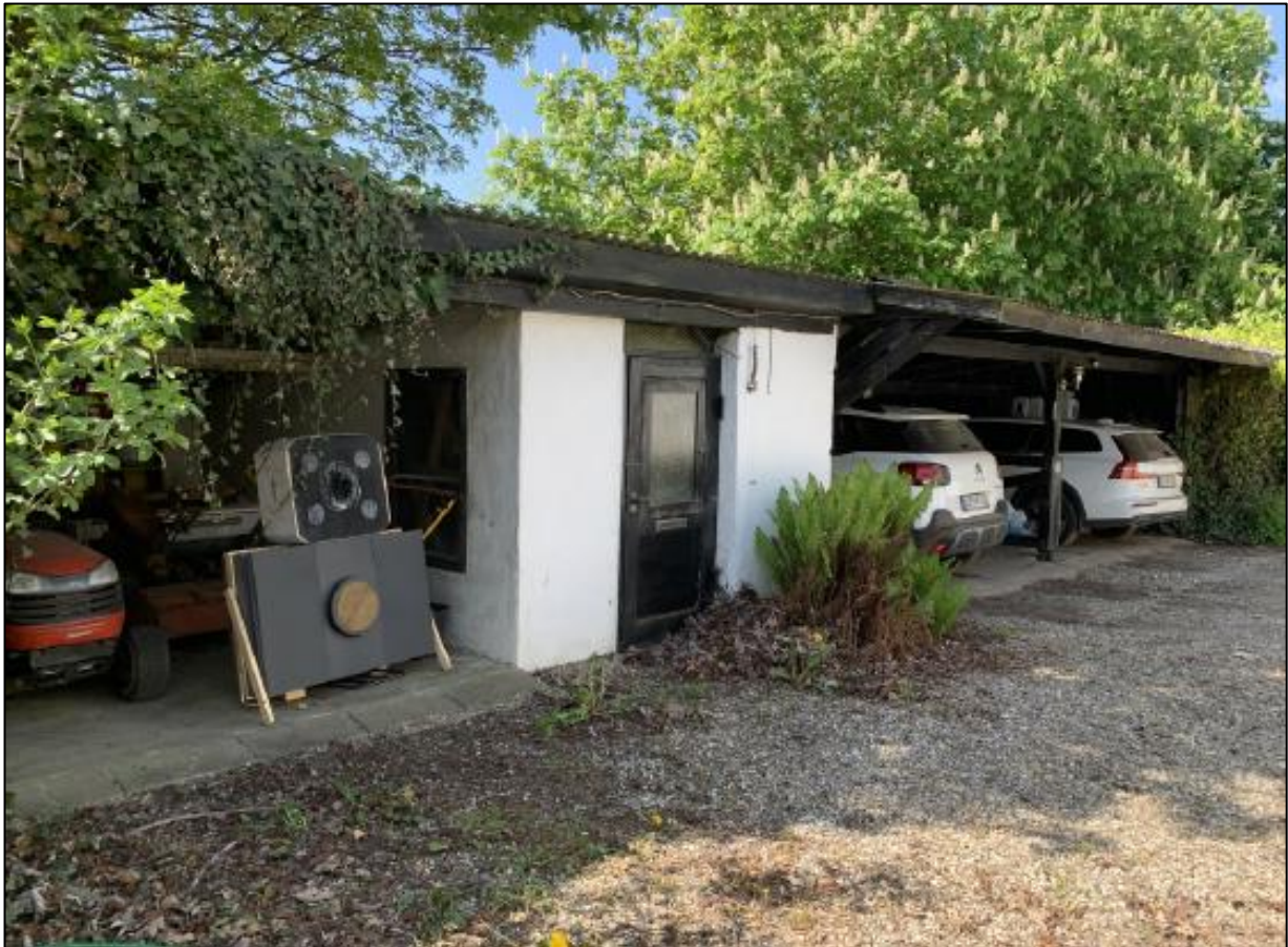
Billede af udhuset med carport og integreret skur. Det er carport-delen til højre, der kræver lovliggørende tilladelse.
