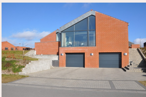
Illustrerende foto til §5 stk.3 og 4 : Eksempel på bolig der er 1 etage på grundens højeste del og 2 etager mod grundens laveste del.
