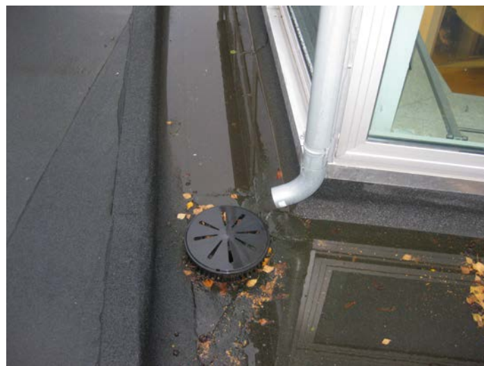
Figur 3 Tagnedløb til UV-system
